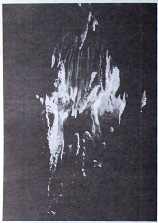
Aspecto na parede Leste da sala maior
