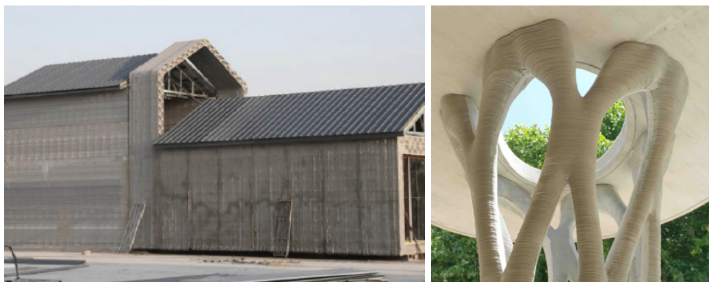
Figura 7. Do convencional às formas orgânicas: diferentes aplicações de cimentosos na arquitetura, desenvolvidos através da impressão 3d. Fonte: SCULPTEO, 2016; WANGLER et al., 2016.
