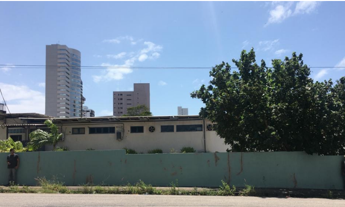
Figura 2. Muro lateral do MCC/UFRN antes da intervenção. Fonte: Fotografia fornecida pelo MCC/UFRN.
