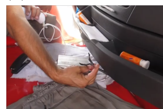
Figura 14. Instalação elétrica improvisada.
