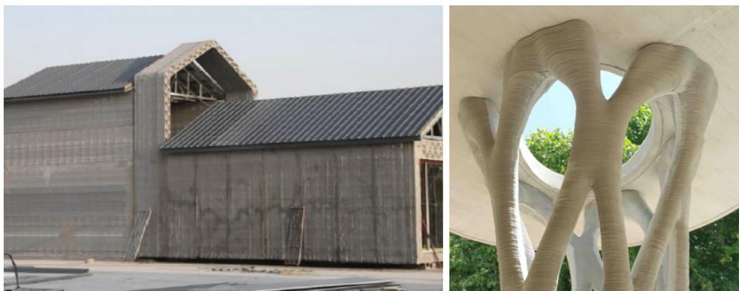
**Figura 7.** Do convencional às formas orgânicas: diferentes aplicações de cimentosos na arquitetura, desenvolvidos através da impressão 3d. Fonte: SCULPTEO, 2016; WANGLER et al., 2016.
