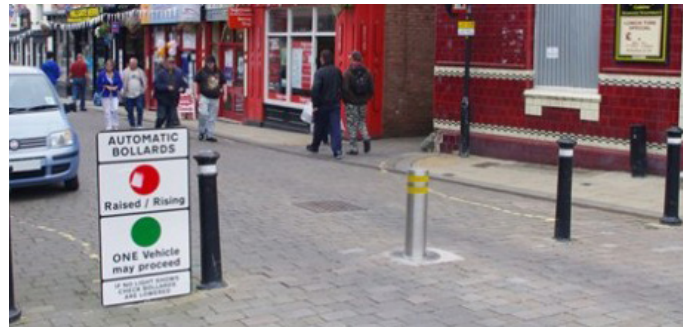
Figura 10. Balizadores retráteis automáticos. Fonte: http://www.electric-gates.com/commercial-gates
